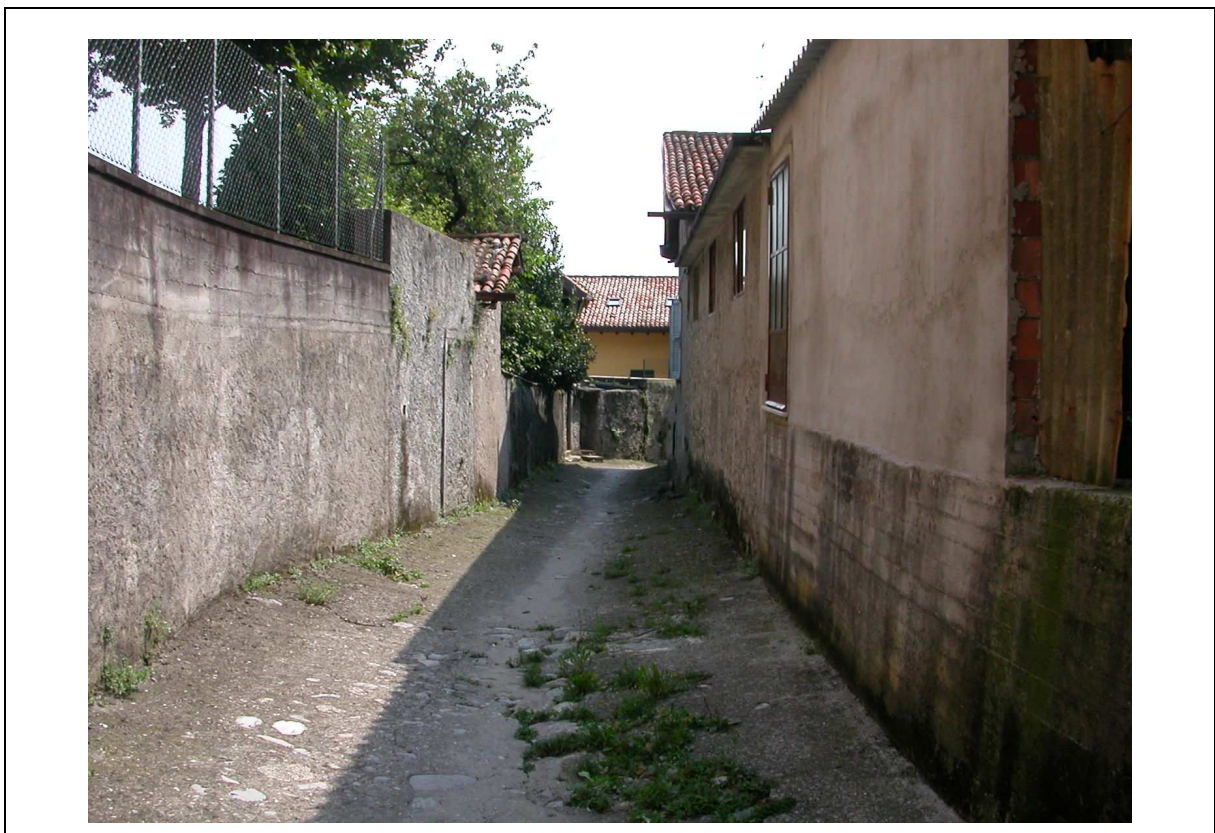
Foto n.11 – Alveo a valle della SS42, compreso tra muri di cinta e muri perimetrali di fabbricati
