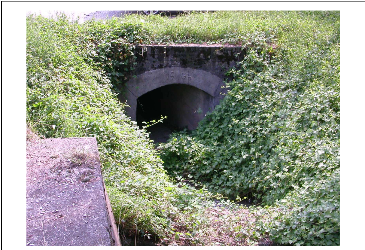
Foto n.15 – Imbocco tratto intubato sotto la SS42
