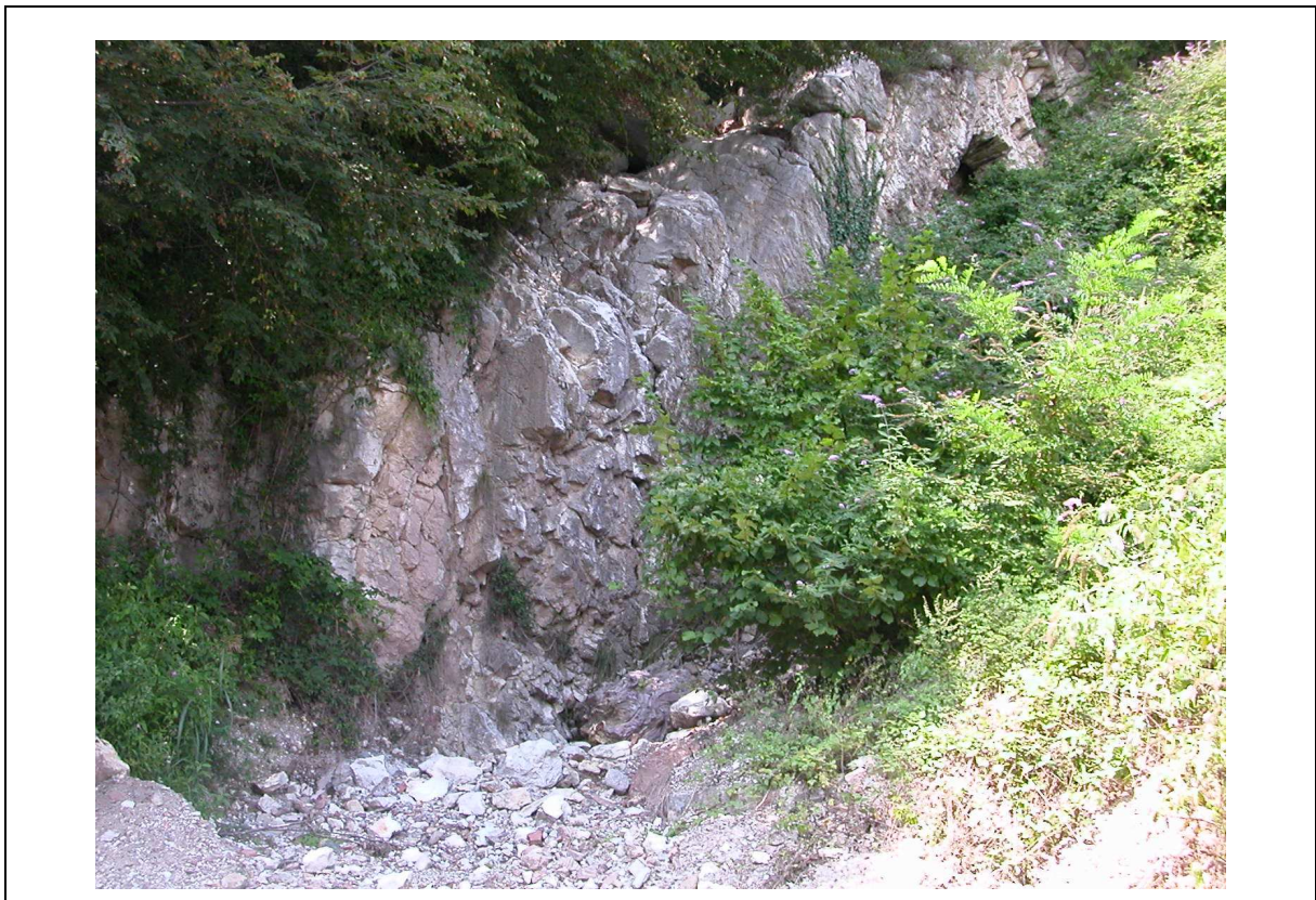
Foto n.7 – Alveo in roccia con salto di quota su parete subverticale nei pressi della cava
