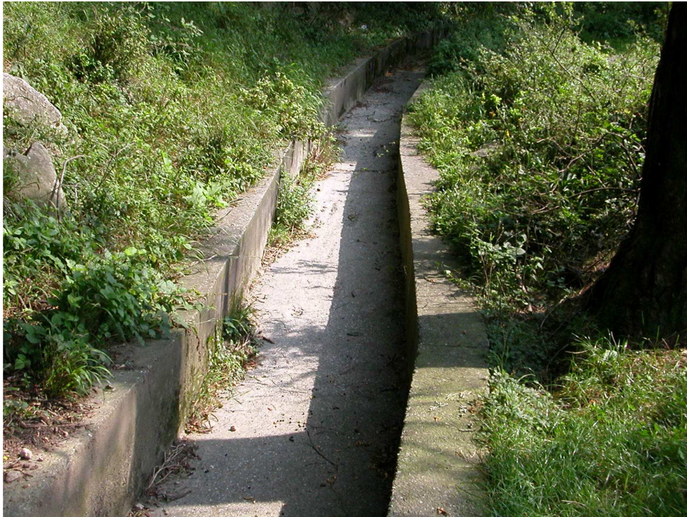
Foto n.1 – Alveo incanalato artificialmente presso C.na Campora (Comune di Eupilio)
