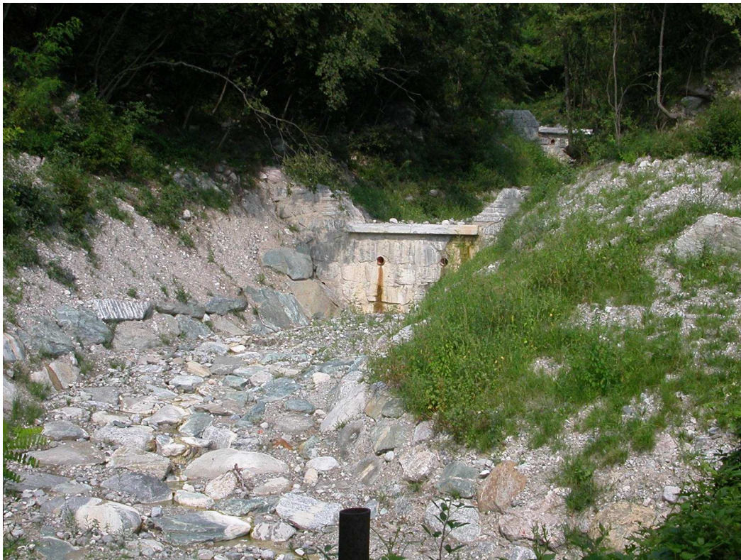
Foto n.3 – Opere di regimazione in prossimità del ponte quota 460 mt s.l.m. sulla strada Carella-Campora
