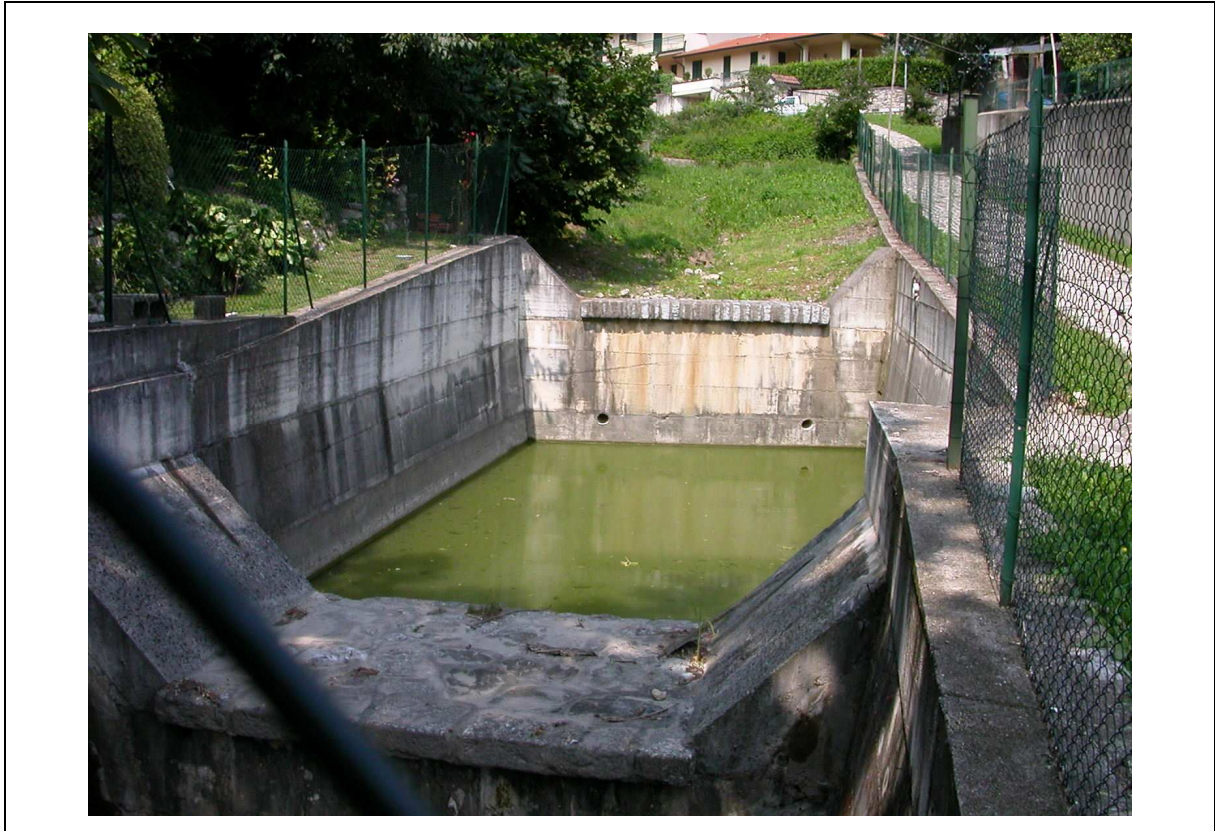
Foto n.10 – Vasche di espansione a monte della SS42
